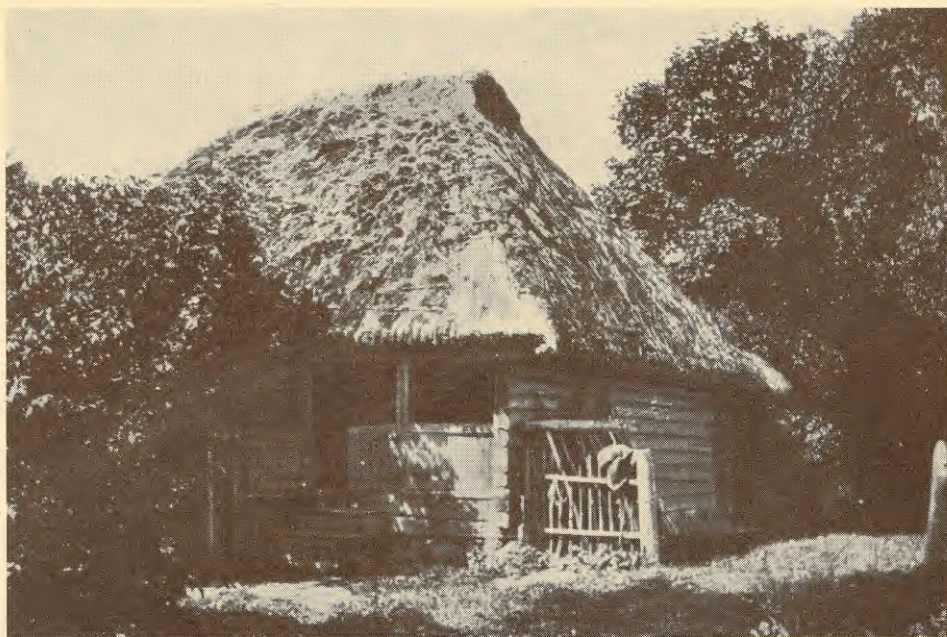
8. att. Dzīvojamā klētis dārza stūrī ar „riņķī grieztu“ jumtu, Skaņkalnes pag. Arch. fak. mat.
