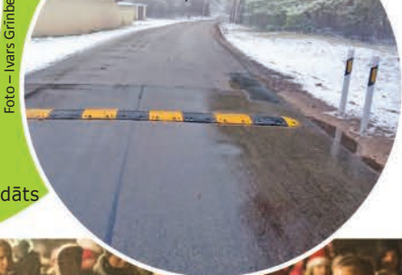
▼ Atjaunoti trīs ātrumvaļņi Alderu ielā, Alderos.
