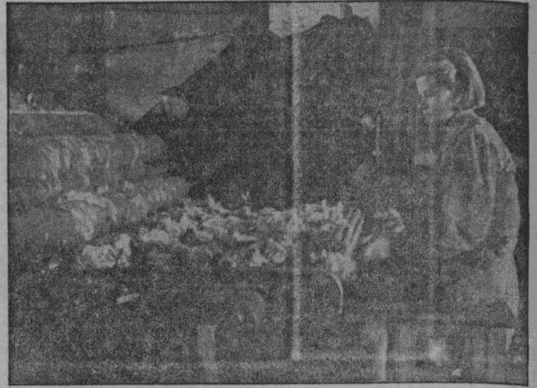
Рассортированную шерсть промывают, а затем пускают в машины, где она превращается в войлок.
