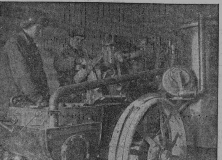
Ввиду недостатка жидкого горючего тракторные моторы перестраиваются на газогенераторные, рассчитанные на древесное топливо. На снимке — монтаж газогенераторного тракторного мотора.
