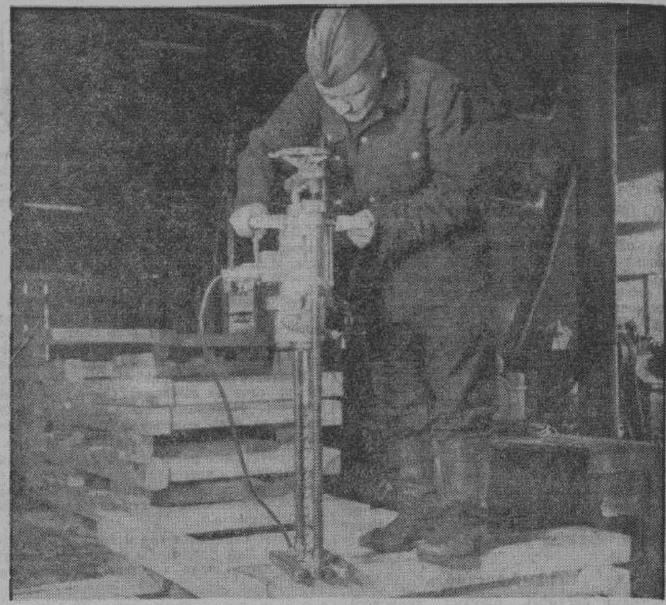
При помощи электрического бурава точнейшим образом просверливаются отверстия для винтов, скрепляющих оси вагонеток.
