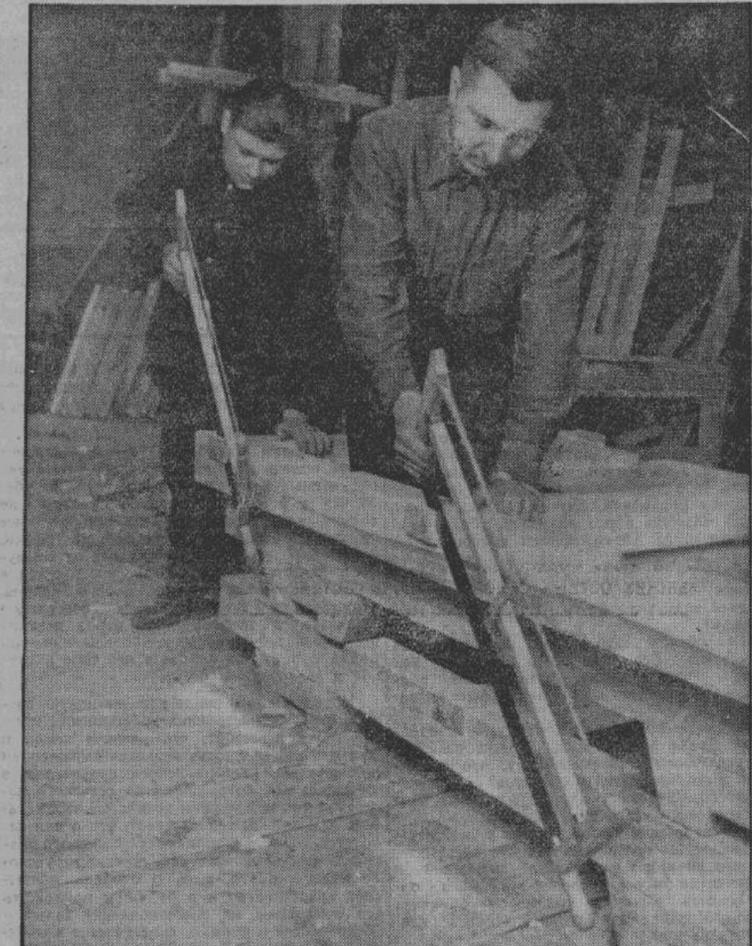
После тщательного измерения лишние куски отпиливаются, и подогнанные части прочно скрепляются гвоздями или винтами.
