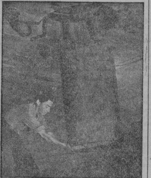
В опускаемом ящике — усиленное давление, чтобы вода и песок не проникали бы внутрь
