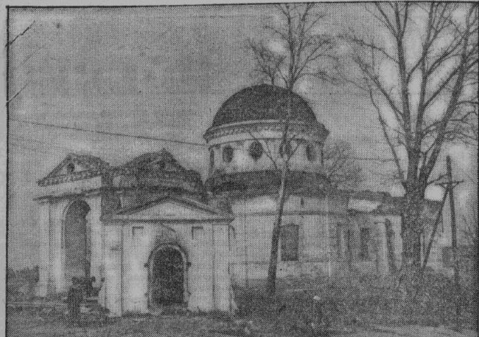
Всюду заметны следы пожаров и разрушений. На снимке — сожженная большевиками церковь в Опочке на Завеличьи
