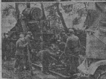
Тяжелая артиллерия на южно-итальянском фронте. На верхнем снимке — германские артиллеристы сооружают фундамент для тяжелой мортиры. Внизу — тягач подводит к фундаменту орудие крупного калибра.
