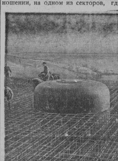
Новый железобетонный бункер, строящийся в глубоком тылу Атлантического вала. На снимке — стальной бункер среди железной арматуры будущей бетонной стены.
