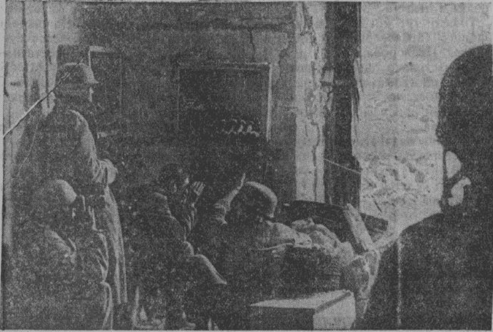
Подвал, разрушенного дома в Кассино, превращенный германскими парашютистами в укрепленный пункт.
