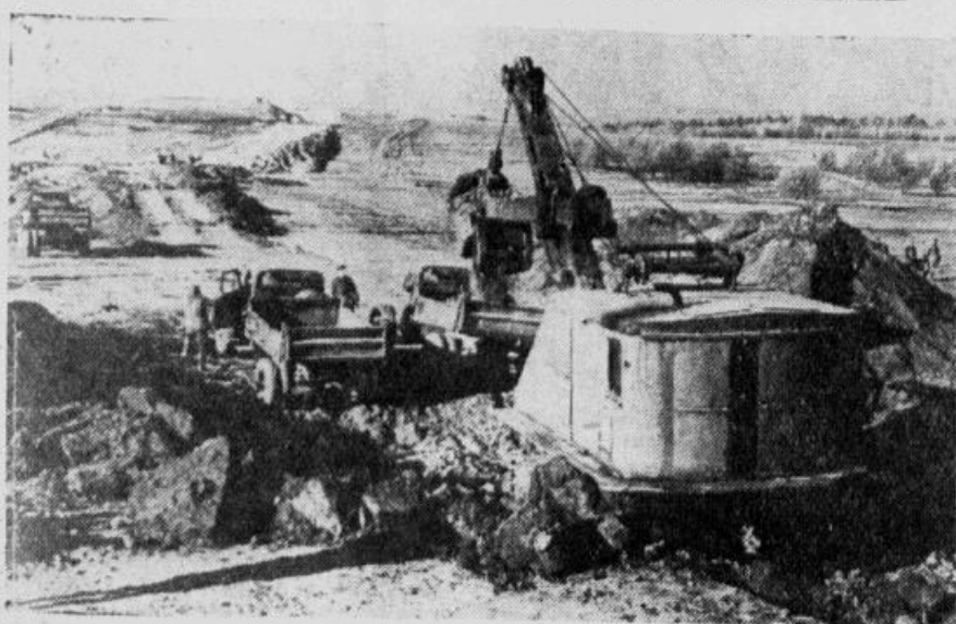
Pievēdēja izbūve uz Kuibiševs hidroelektrostacijas celtniecības laukumu
