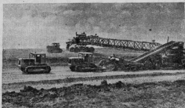
Hersonas apgabals. «Ukrvodstroja» celtnieku kolektīvs izbūvē Krasnoznamenaskas kanālu. Pabeigti būvdarbi, lai kanāla pirmajā posmā ielepludinātu Kachovkas jūras ūdeni. Kanāla otrajā posmā rakšanā iesaistīti greideri — ēvēli.
