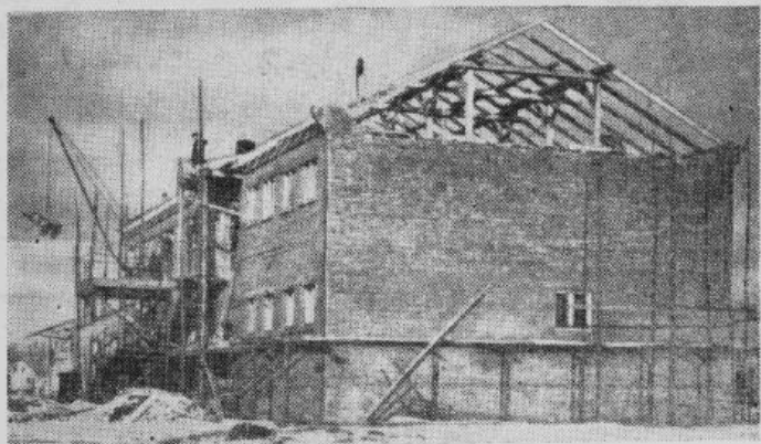
Attēlā: kompleksās noliktavas būvniecība.
