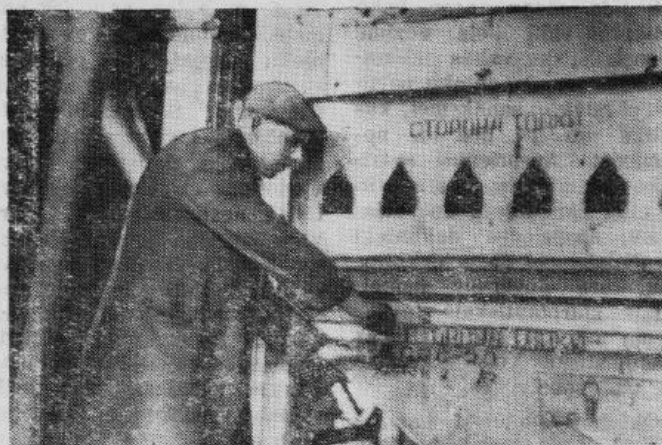
Ar jaunās graudu kaltes iekārtošanu nevajadzēs vairs lietot primitīvās kaltes. Līdz ar to atbrīvosies vairāki cilvēki, jo kalti SZS-2 apkalpo tikai divi cilvēki. Attēls: jaunās graudu kaltes montēšana.
