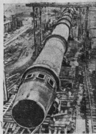
Čehoslovākijas republikā netālu no Banskā-Bistricas (Slovākijā) pēc padomju inženieru projekta cel vienu no lielākām cementa rūpniecības.
