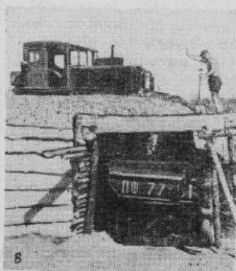
Attēls: pie karjeras arī smiltis iekrauj automašīnā ar traktora un estakades palīdzību.
