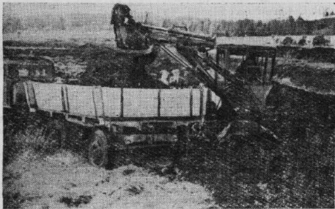
Attēlā: ekskavators iekrauj kūdrā traktora piekabī.
