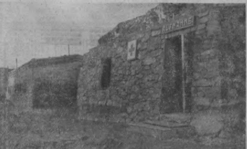
nur wenige Kilometer hinter den vordersten Linien sind mehrere mächtige Bunker errichtet worden. Sie gehören zum Hauptverbandplatz, der nach den neuesten Erfahrungen bomben- und splittersicher erbaut wurde
