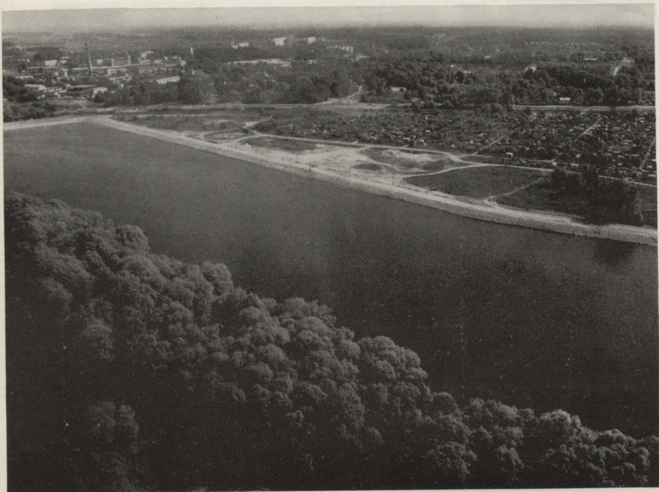
Торожаис Rīgas airēšanas kanāls Daugavā pie Lucavsālas. Здесь будет гребной канал (на реке Даугава у острова Луцавсала). Riga rowing canal under construction in Daugava near Lucavsala.
