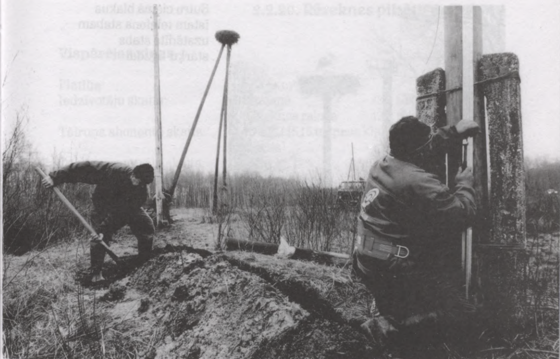
Aglonas–Preiļu autoceļa malā Anspoku ciema tuvumā gaisvadu līniju nomaina kabeļlīnija
