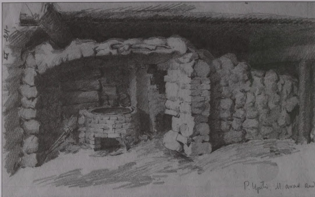
19. att. Ap 1830. gadu (?) no laukakmeņiem mūrēta rijas krāsns Cēsu apr. Sērmūkšu pag. Drēzdenēs 1928. gadā. Zīmējis Latvijas Mākslas akadēmijas students Pēteris Upītis (LNVME mape Cēsu apr., „Rijas krāsns”, 205. dok.). Krāsns priekšā senlaicīga ugunsdroša kulda („velve”), kuras lokveida pārsegums darināts no liektām koka līkstēm un māliem (sal. 17. gadsimta rovja būves aprakstu 43. lpp.).
