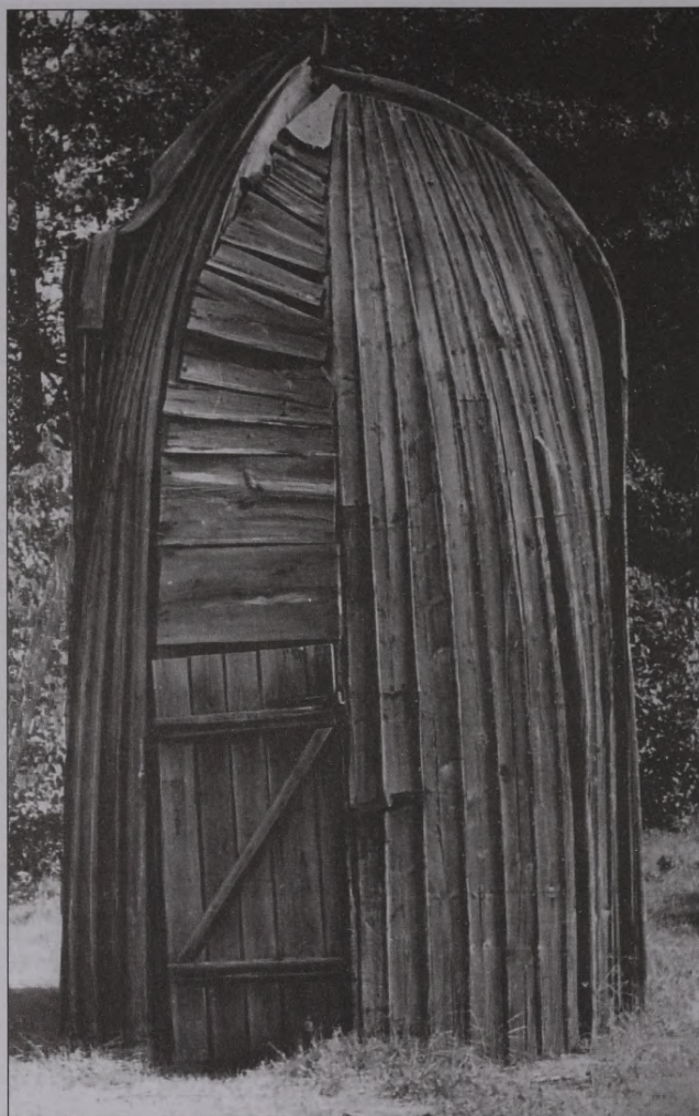
4. att. No pārzāgētas laivas daļām veidota āra virtuve – zivju kūpinātava („dūmnams”) Talsu raj. Kolkas pag. Mazirbes Kalšos 1965. gadā. S. Cimermaņa foto (E 1442. f., 31. k.)
