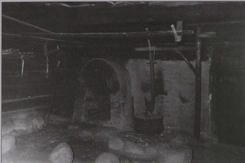
8. att. Senlaicīga nama–virtuves iekārta (atklāts pavards ar grozāmā kāšī pakārtu katlu, maizes krāsns kurtuve ar arkveida dzirksteļu uztvērēju un trijkājiem katlu un pannu uzlikšanai, līmenisks, ar māliem nosmērēts plēstu apaļkoku pārsegums – rovis) ap 1750. gadu celtajā Liepājas apr. Rucavas pag. Nidas ciema Kūršu bezdūmeņa dzīvojamā mājā. Kopš 1939. gada Latvijas Etnogrāfiskā brīvdabas muzeja Kurzemes sektorā. S. Cimermaņa foto 1967. gadā
