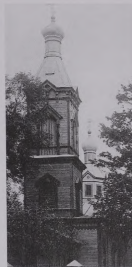
49. Skrudalienas pareizticīgo baznīca
