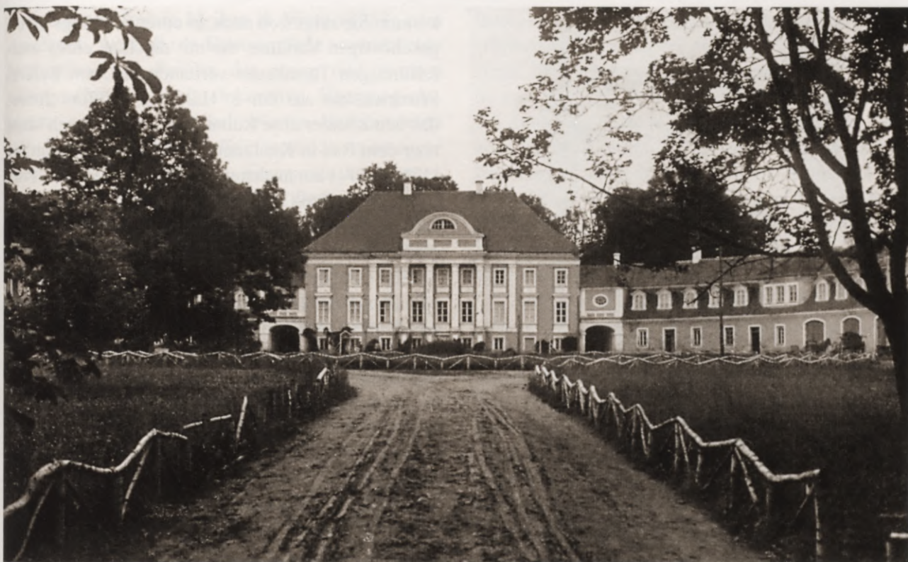
34. Skats uz Kaucmindes pils pagalma fasādi pēc pārbūves. Foto ap 1912. g. Blick auf die Hoffassade nach dem Umbau. Foto um 1912
