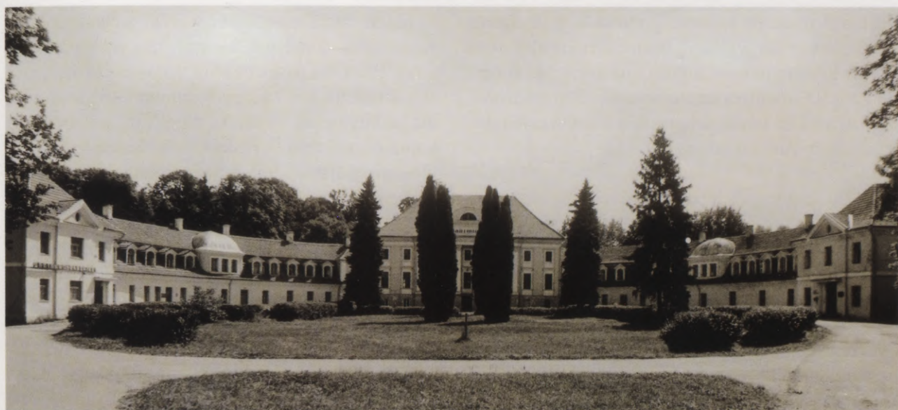
15. Kaucmindes pils pagalma fasādes kopskats. 1990. g. foto Gesamtansicht der Hoffassade. Foto 1990
