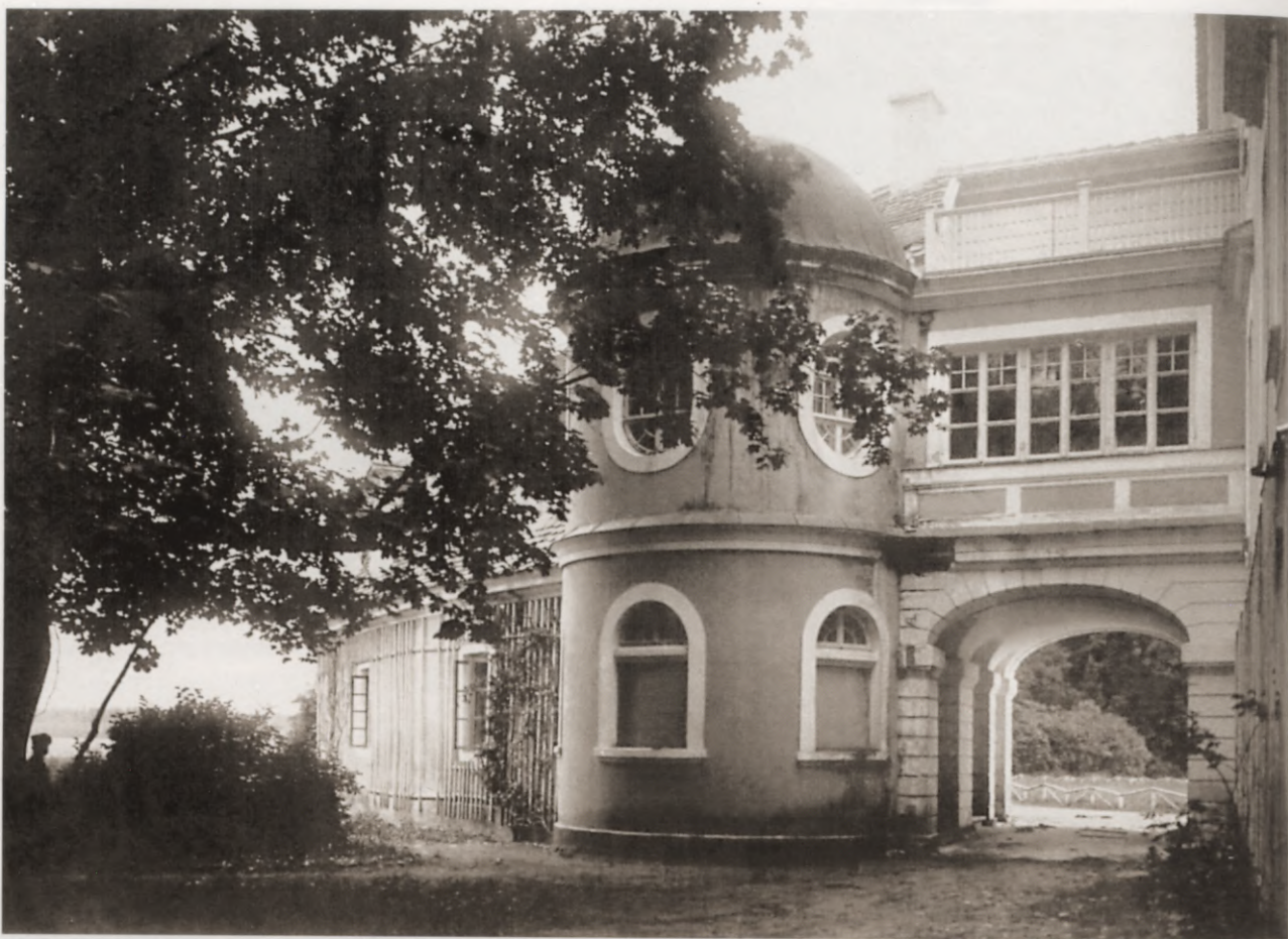
44. Dienvidu puses caurbrauktuve, skats no parka puses. Foto ap 1912. g. Südliche Durchfahrt von der Parkseite. Foto um 1912
