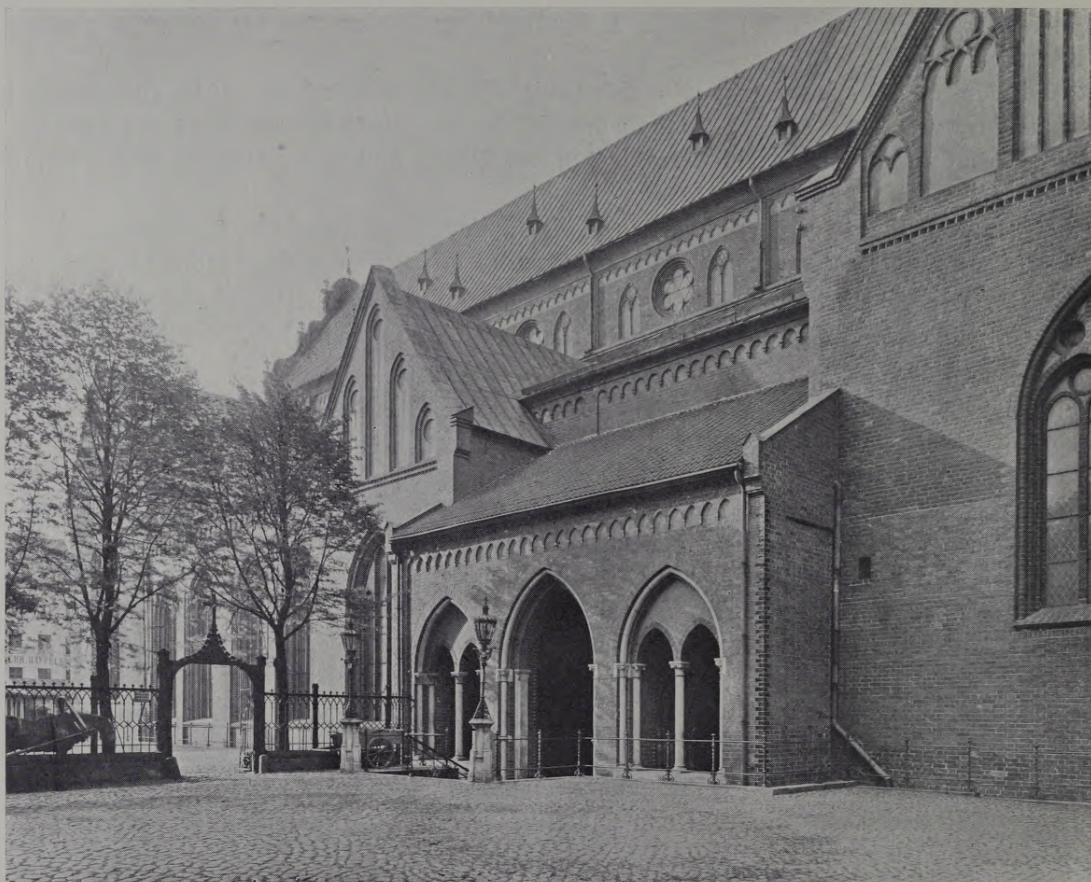
Abb. 65. Die Nordseite des Domes nach der Wiederherstellung.
