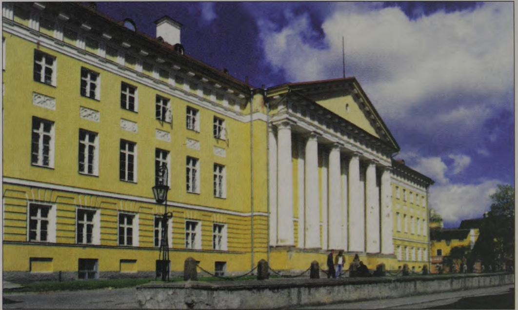
199. att. J. V. Krauze. Tērbatas Universitātes galvenā ēka . 1803–1809.
