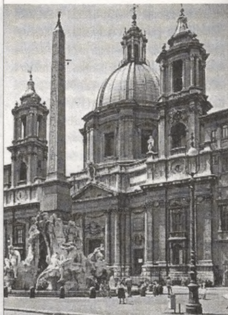
Baroks. F. Borromīni. Santanžēzes baznīca Navona laukumā Romā. 1652 – 1657
