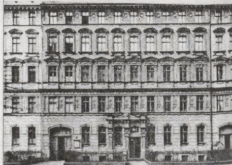
Eklektisms. J. F. Baumanis. Nams Merķeļa ielā 7. 1883
