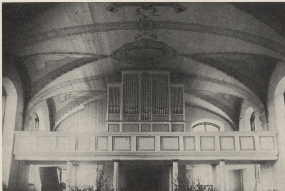
94. att. Lēdurgas baznīcas velves.
