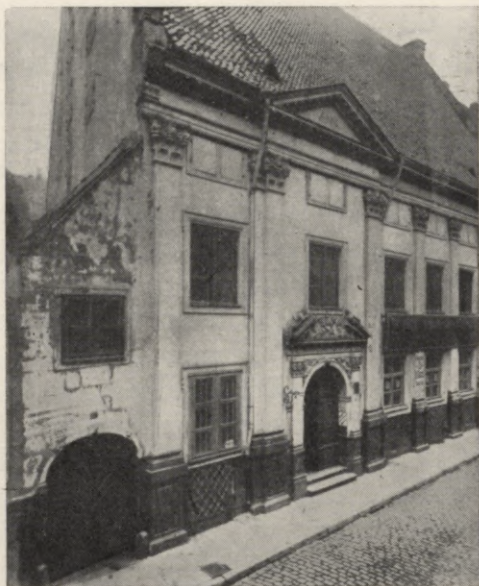
102. att. «Danenšterna nams» Rīgā.
