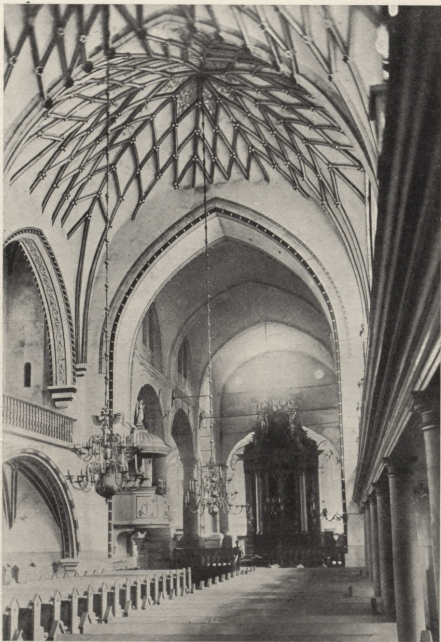
3. att. Skats Jāņa baznīcas piebūvē no gotiskām telpām.
