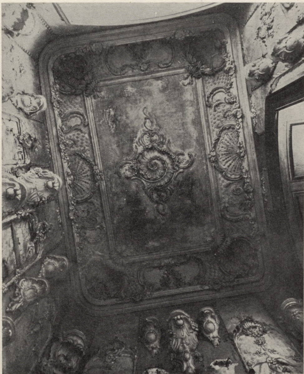
124. att. Rundāles pils. Griestu izrotājums.
