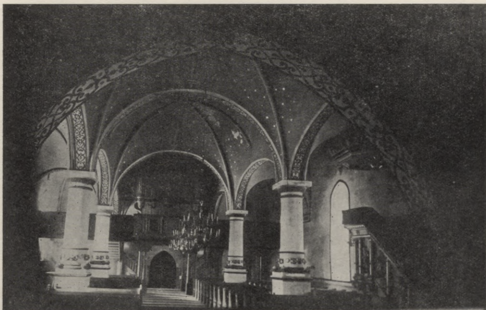
9. att. Katrīnas baznīca Kuldīgā. Iekšskats.
