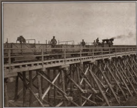
Vāciešu celtais dzelzceļa tilts no Aizputes uz Skrundu 1916. gadā
