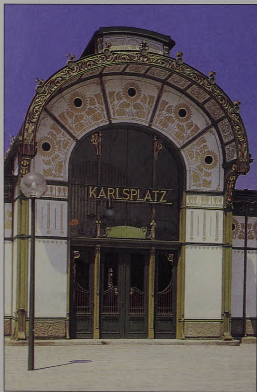
9. att. O. Vāgners. Dzelzceļa stacija “Karlsplatz” Vīnē. 1894–1897.
