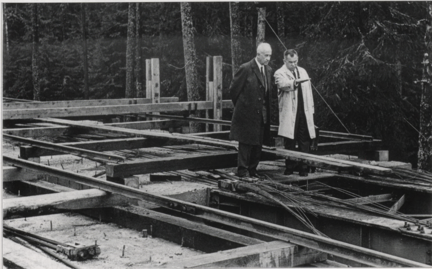
42. attēls. Uz topošā viadukta laiduma redzami tālaika ievērojamākais tiltu lietu speciālists Maskavas profesors E. Gibšmanis (1905-1973) un autors gida lomā.
