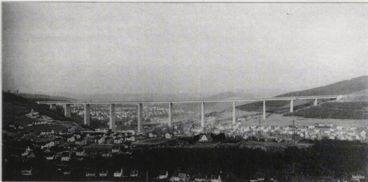
4. attēls. 1050 m garais Eiserfeldes gravas viadukts ar 63-105 m lieliem laidumiem.
