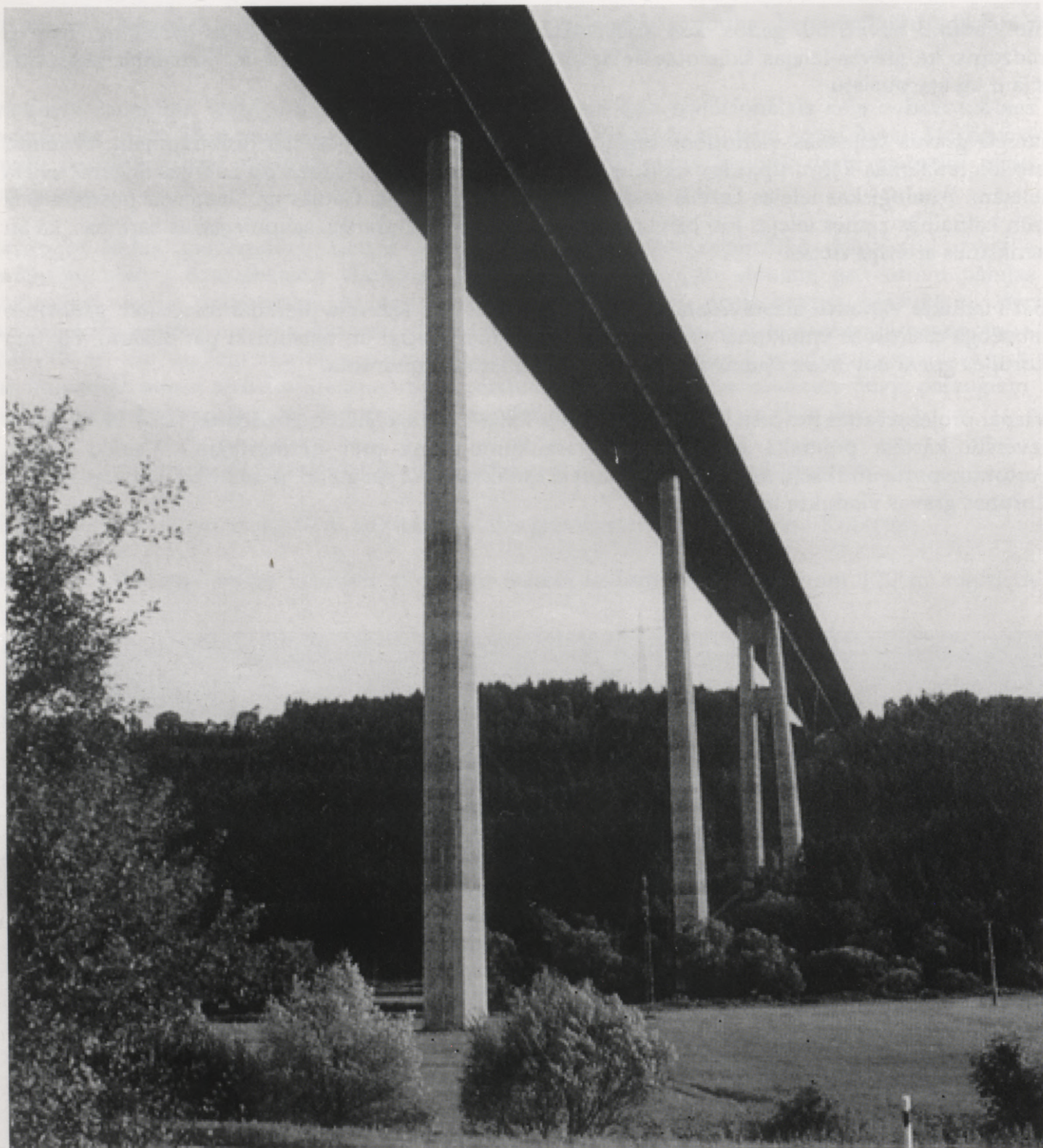
6. attēls. Nekaras gravas viadukts ar 134 m lieliem laidumiem un apmēram 120 m augstiem balstiem.
