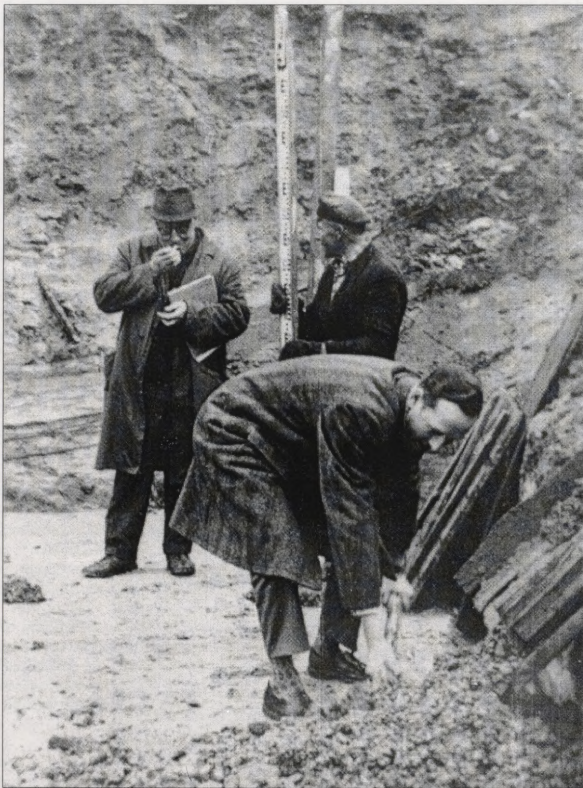
37. attēls. Simbolisku betonmasas iestrādāšanu starpbalsta pamatā veic toreizējais Ceļu pārvaldes priekšnieks inženieris H. Sviķis (dz. 1927. g.). Pirmais no kreisās - būvdarbu vadītājs inženieris E. Grunte (1909-1990).
