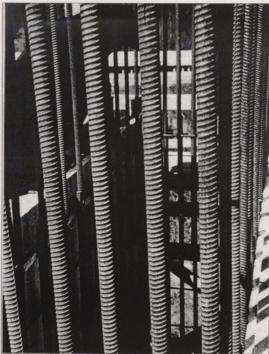
34. attēls. 90 cm biezā starpbalsta stiegrojums.
