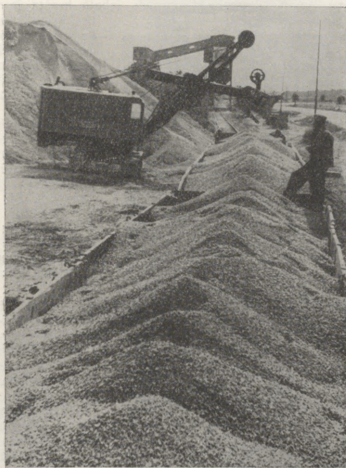
83. att. Dolomītu šķembu iekraušana platformās Pļaviņu dolomīta lauztuvē
