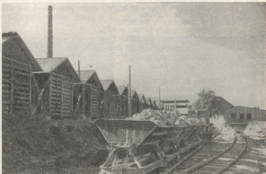
68. att. Kelera tipa ķieģeļu žāvēšanas šķūņi Tūjas ķieģeļu rūpnīcā
