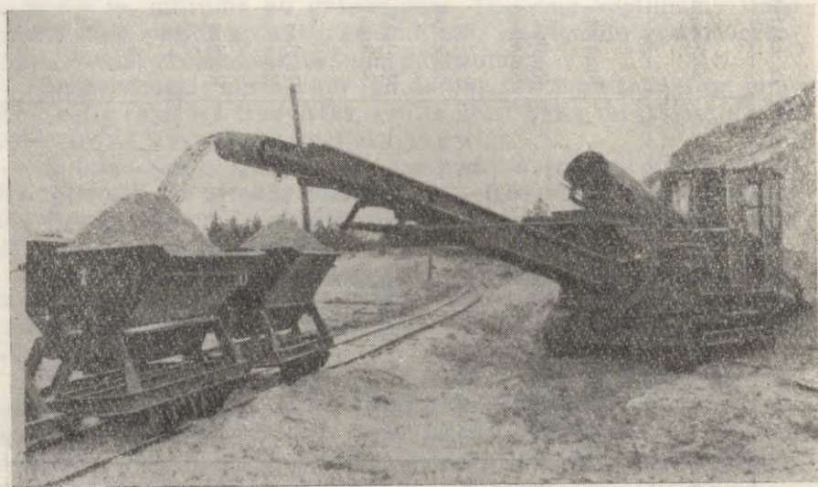
31. att. Smilšu iegūšana silikātķieģeļu ražošanai ar frēzlāpstu
