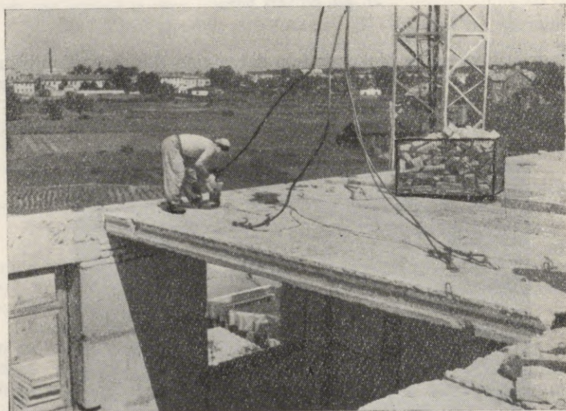
23. att. Starpstāvu dobās pārseguma plāksnes
