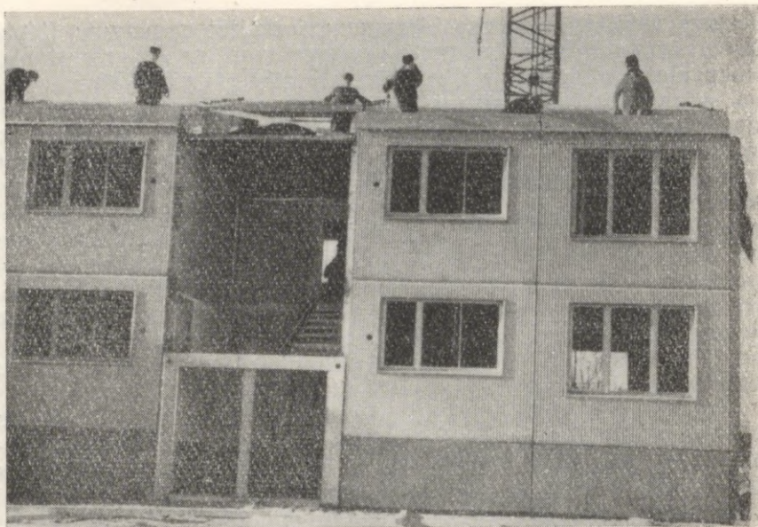
27. att. Paneļu mājas būve Ļeņina rajonā
