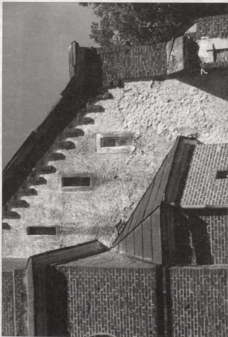
9. Vilkenes Sv. Katrīnas baznīcas rietumu fasādes fragments ar t.s. šaujamlūku tipa logaļām (2001. g. jūlija foto).
