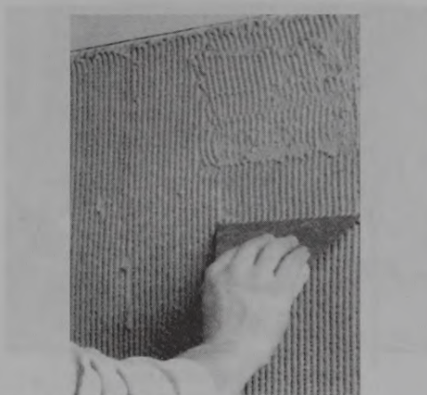
3.49. att. Ar zobšpakteļi viļņveidīgi ieklātā līmjavas kārta
