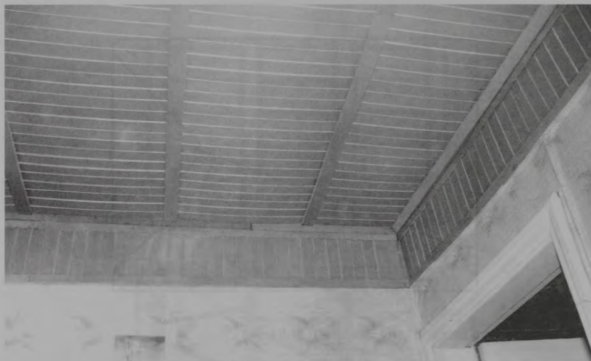
2.78. att. Griestu un sienu augšējās apmales apšuvums ar saplākšņa gultas līstēm
