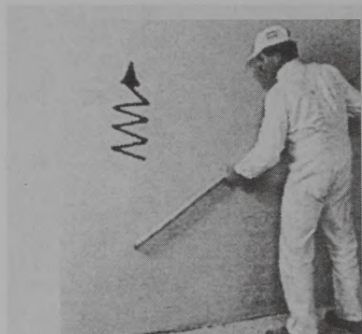
1.48. att. Apmetuma izlīdzināšana
