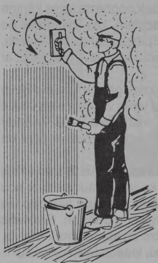
1.25. att. Apmetuma apdares kārtas riņķveidīga norīvēšana
