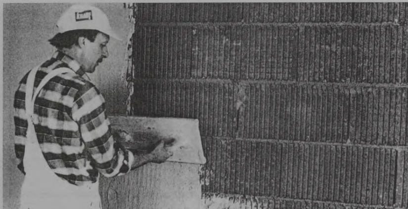
1.47. att. Ģipša sausā maisījuma apmetuma javas uzstrādāšana ar uzvelkamo dēli
