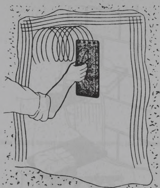
1.59. att. Uzcirtumu izveidošana apmetumā ar rīvdēli iedzītām naglām
