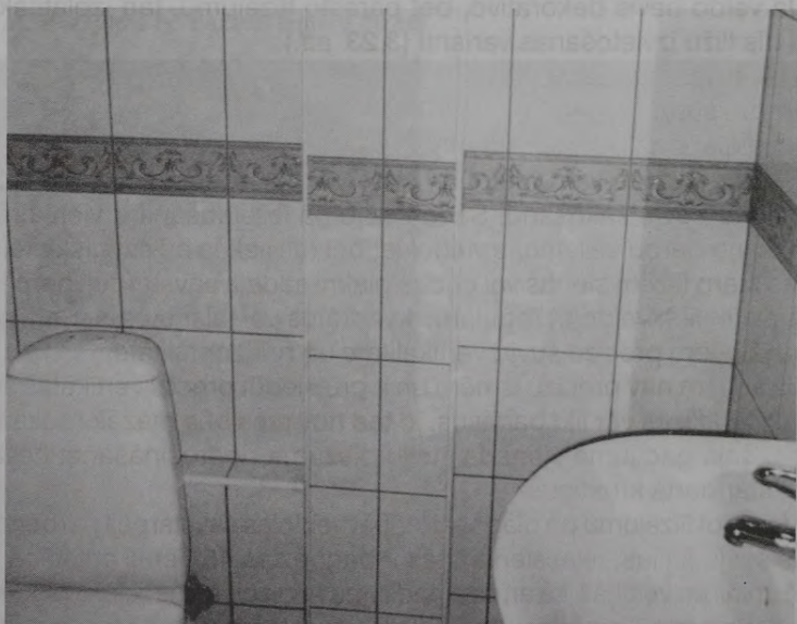
3.24. att. Piegrieztās nepilnās flīzes sienā ar izvirzījumiem
