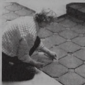
3.62. att. Kvadrātveida flīžu ieklāšana kombinācijā ar astoņstūrveida flīzēm: a – līmes ieklāšana; b – astoņstūrveida flīžu ieklāšana; c – kvadrātveida flīžu ieklāšana; d – ieklātais grīdas flīzējums
