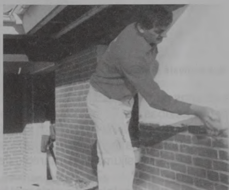
1.53. att. «Dāņu» apmetuma iestrādāšana: a – uzklāšana; b – nolīdzināšana ar sūkli
