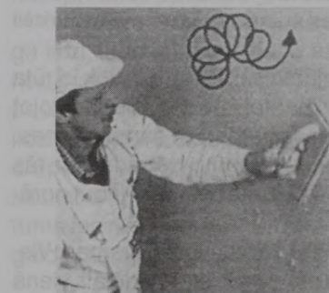
1.50. att. Apmetuma norīvēšana
