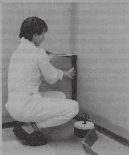
3.25. att. Stūra salaīduma vietas hidroizolācijas ierīkošana
