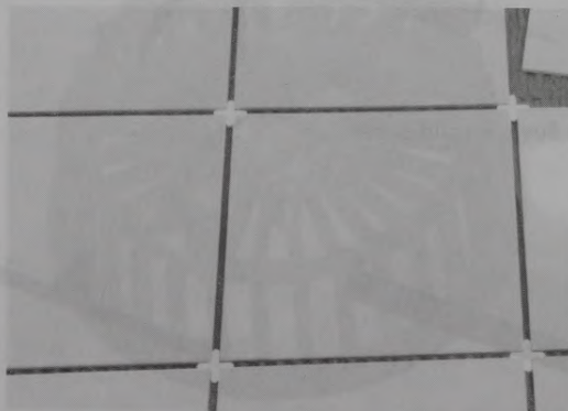
3.19. att. Plastmasas krustiņi vienāda platuma šuvju nodrošināšanai starp flīzēm
