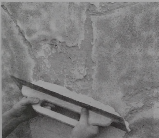
1.66. att. Pamatapmetuma uzklāšana uz saplaisājušās virsmas ar metāla rīvdēli
