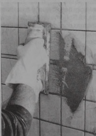
3.68. att. Šuvju aizpildītāja iespiešana flīzējuma šuvēs ar rīvdēli
