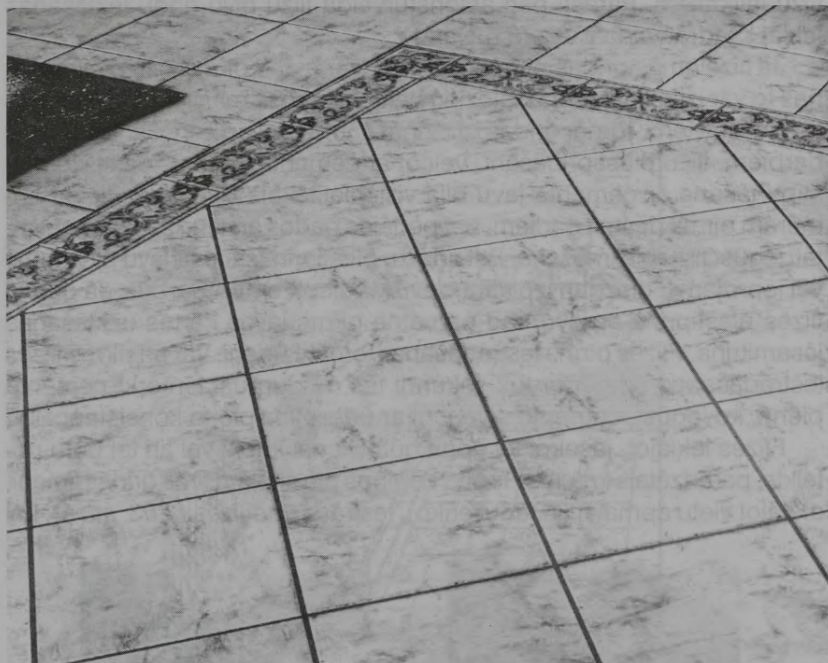
3.61. att. Flīžu ieklāšana pēc diagonālā flīžu izvietojuma shēmas
