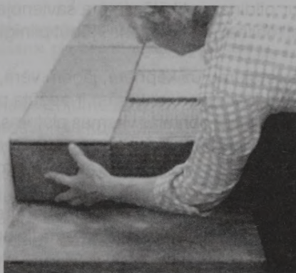
3.66. att. Kāpņu pildiņa flīzes iestrādāšana zem kāpšļa flīzes
