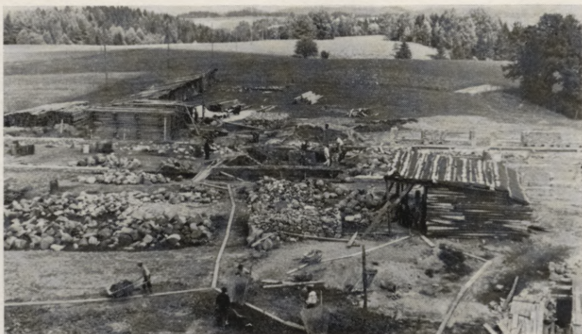
Ratnieki pārbūves laikā
