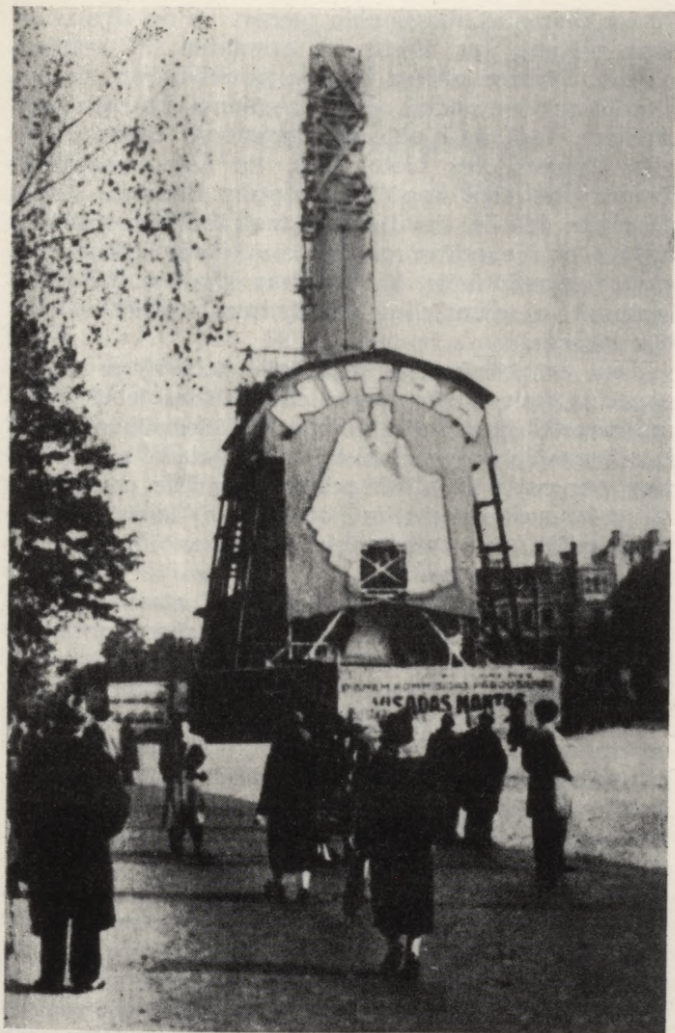
Brīvības pieminekļa būvlaukums 1935. gada augustā. E. Štālberga foto.
