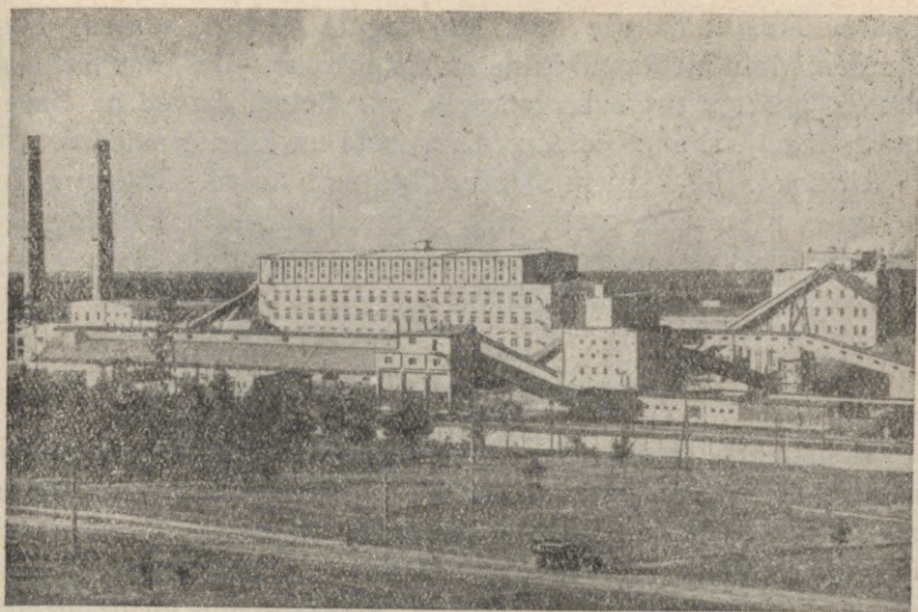
Azbesta bagātināšanas fabrika Azbestas pilsētā, Sverdlovskas apgabalā.
