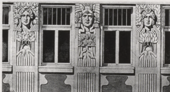
12. Plūmes nams Blaumaņa ielā 8. Fasādes fragments
