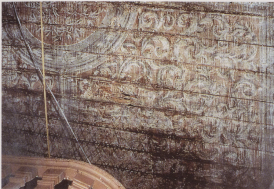
12. Mārstaļu iela 21. Dannenšterna nams. Gleznojums uz tapotiem siju griestiem. 17. gs. beigas–18. gs. sākums
