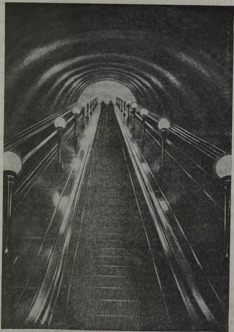
Šeit valda tikai elektrība. Apgaismojums apakšzemes dzelzceļa tunelī.
