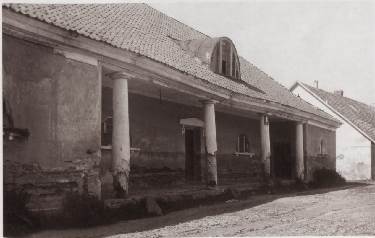
45. Klēts. 1929. g. foto. Kornspeicher (Kleete). Foto 1929.
