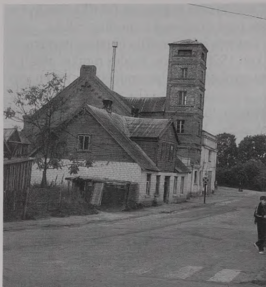
Jaunais ugunsdzēsēju depo Skrundas ielā
