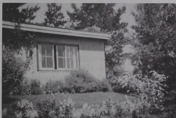
Jaunā piebūve no „sētas puses”
