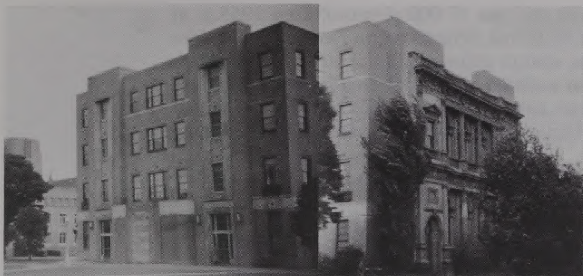
Architektūras šedevrs – Melburnas universitātes tautsaimniecības fakultātes ēka (moderna stila celtni piebūvēta kāda agrākā bankas nama fasāde)
