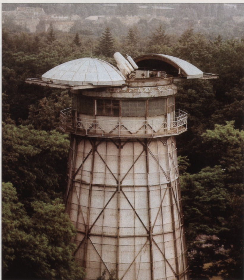
Lāzera tālmērs Potsdamā, kas paredzēts ZMP novērošanai. Teleskopa objektīva diametrs 40 cm, rubīna lāzera jauda 40 MW, impulsa ilgstība 3 ns, atkārtšanas periods 6 s
