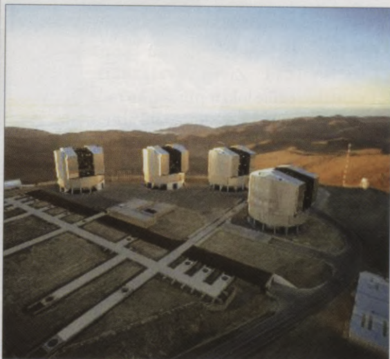
Eiropas Dienvidu observatorijas Čilē Ļoti lielais teleskops sastāv no četriem teleskopiem, kuru spoguļu diametrs ir 8,2 m
