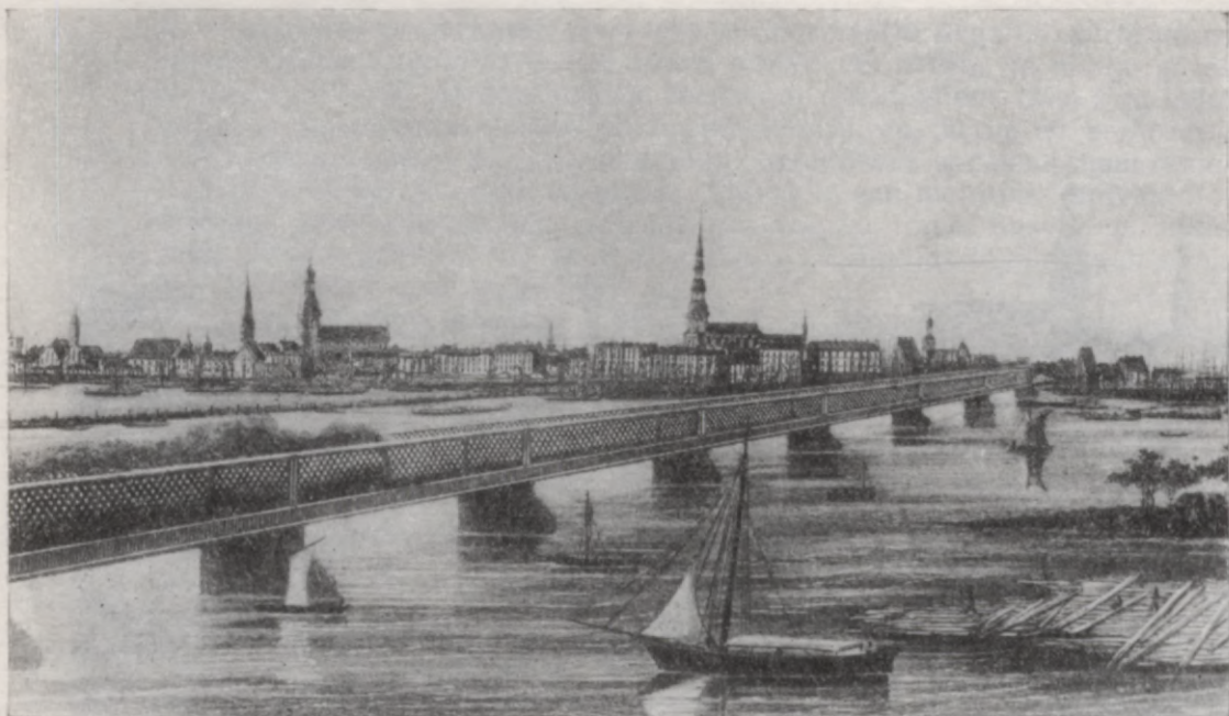
19. gs. 70. gadu sākumā uzbūvētais dzelzceļa tilts Rīgā.
