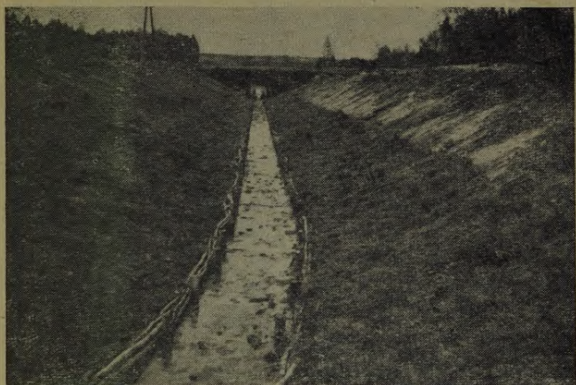
3. att. Drenāžas novadgrāvis Rimeiku izmēģinājumu objektā
