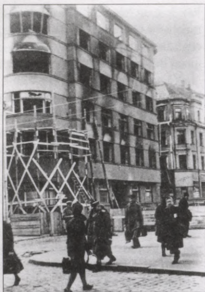
Vācu sapieru nopostītā telefona centrāles ēka Rīgā, Audēju ielā 15 (1944)
