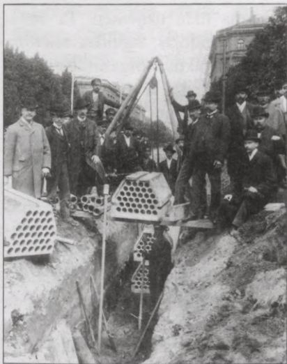
Telefona kabeļu montāžas darbi 1902. gadā Rīgā, Suvorova ielā (tagad K. Barona iela)
