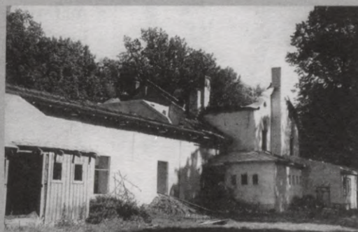
Nodegušais kultūras nams no sētas puses, 1963
