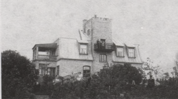
Krastiņu māja, 1926. Tagad Slimnīcas ielā 33
