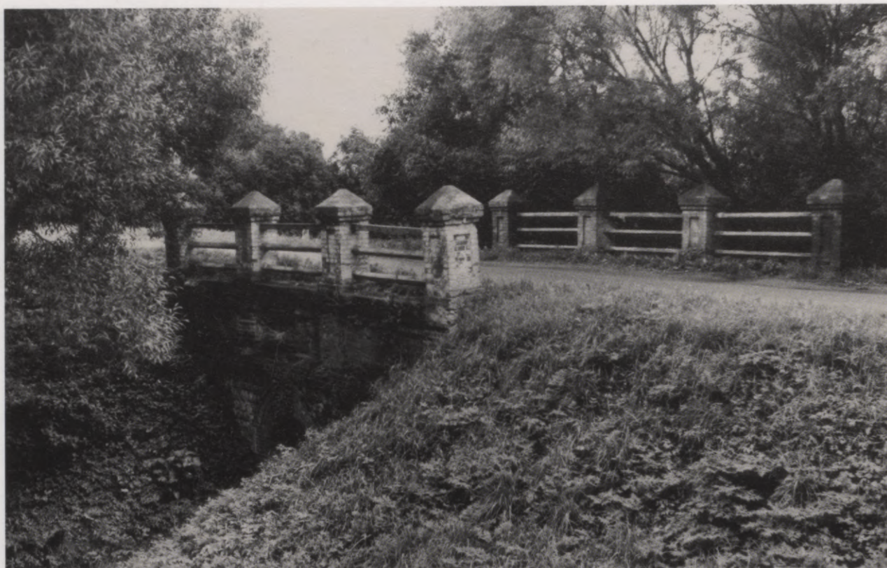
29. Ap 19. un 20. gs. miju būvētais tiltiņš pār Riju strautu uz Jēkabpils lielceļa. 1991. g. foto. Brücke über den Riju-Bach an der Landstraße nach Jakobstadt, erbaut an der Wende 19./20. Jh. Foto 1991.
