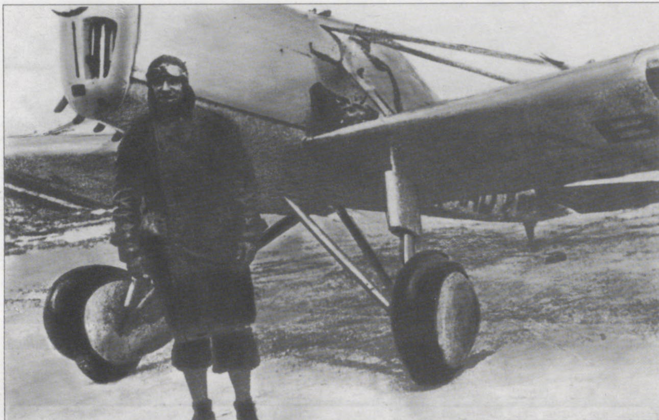
H. Cukurs ar savu C-3 pēc Vidusjūras šķērsošanas ceļā no Gambijas uz Rīgu. Vecā "Renault" dzinēja vietā jau uzstādīts jauns "De Havilland Gipsy Major" (foto no A. Gerbera personiskā arhīvā)
