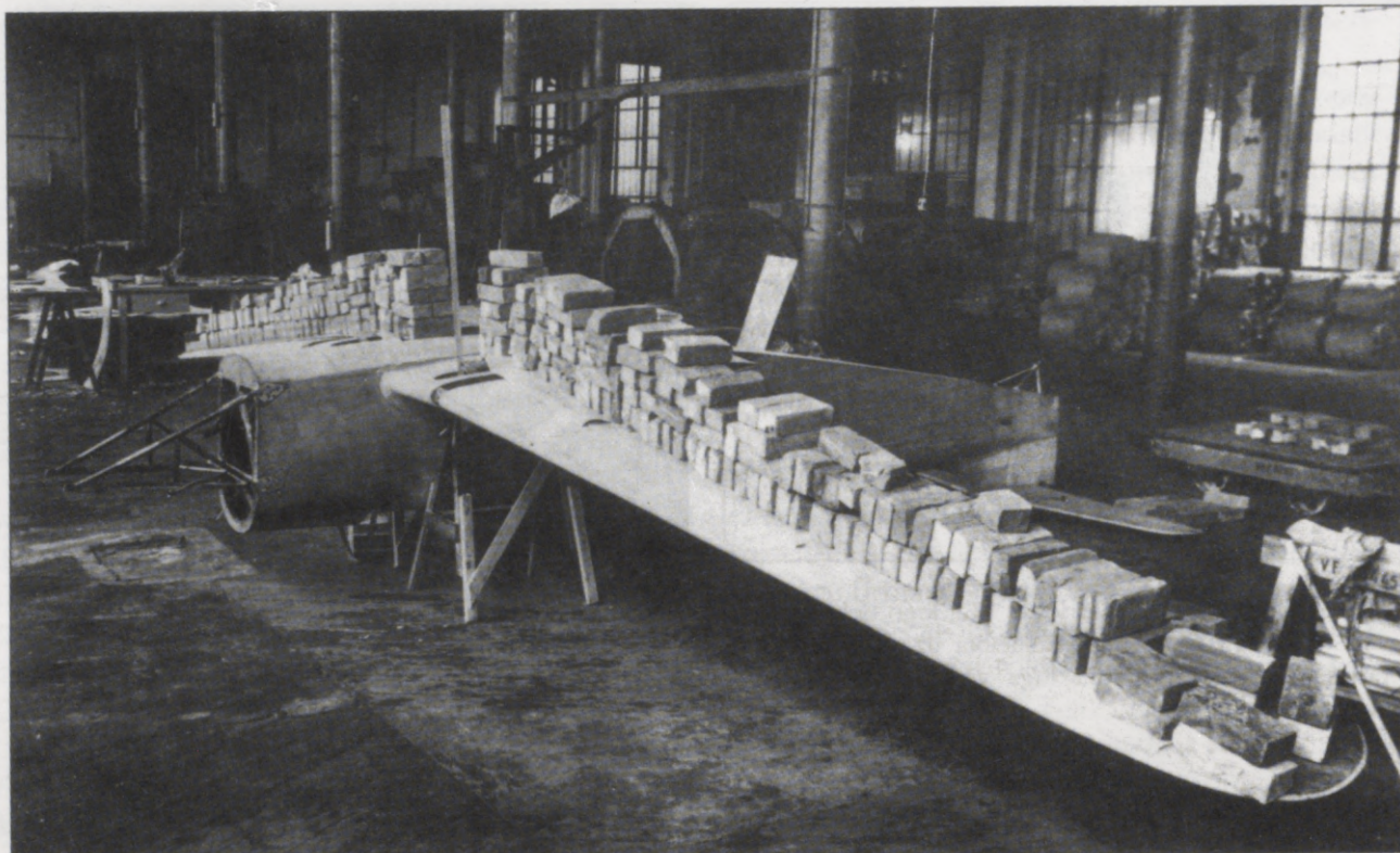
Pirmās VEF'ā būvētās lidmašīnas I-11 spārns slodzes pārbaudē
