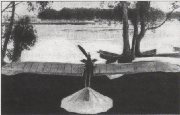
A. Rozentāla lidmašīna, konstruēta un uzbūvēta 1913.—1914. gadā. Trīscilindru 25 ZS "Anzani" dzinējs, analogs dzinējam, kādu izmantoja Luijs Blerio (Francija) savās lidmašīnās (foto no A. Gerbera personiskā arhīva)
