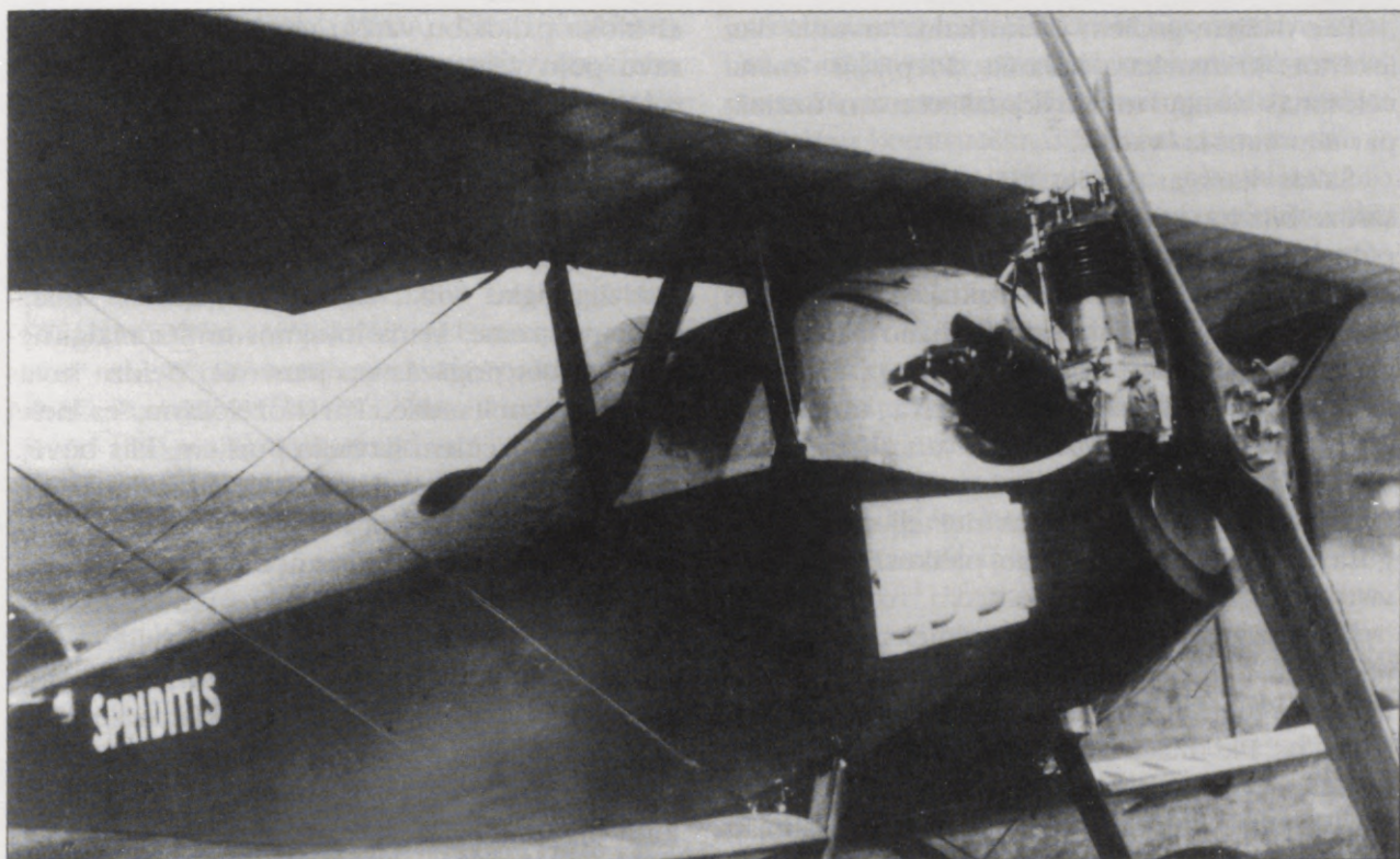
Mazjaudīgais 25 ZS "Anzani" motors nodrošināja "Sprīdiša" lidojumus
