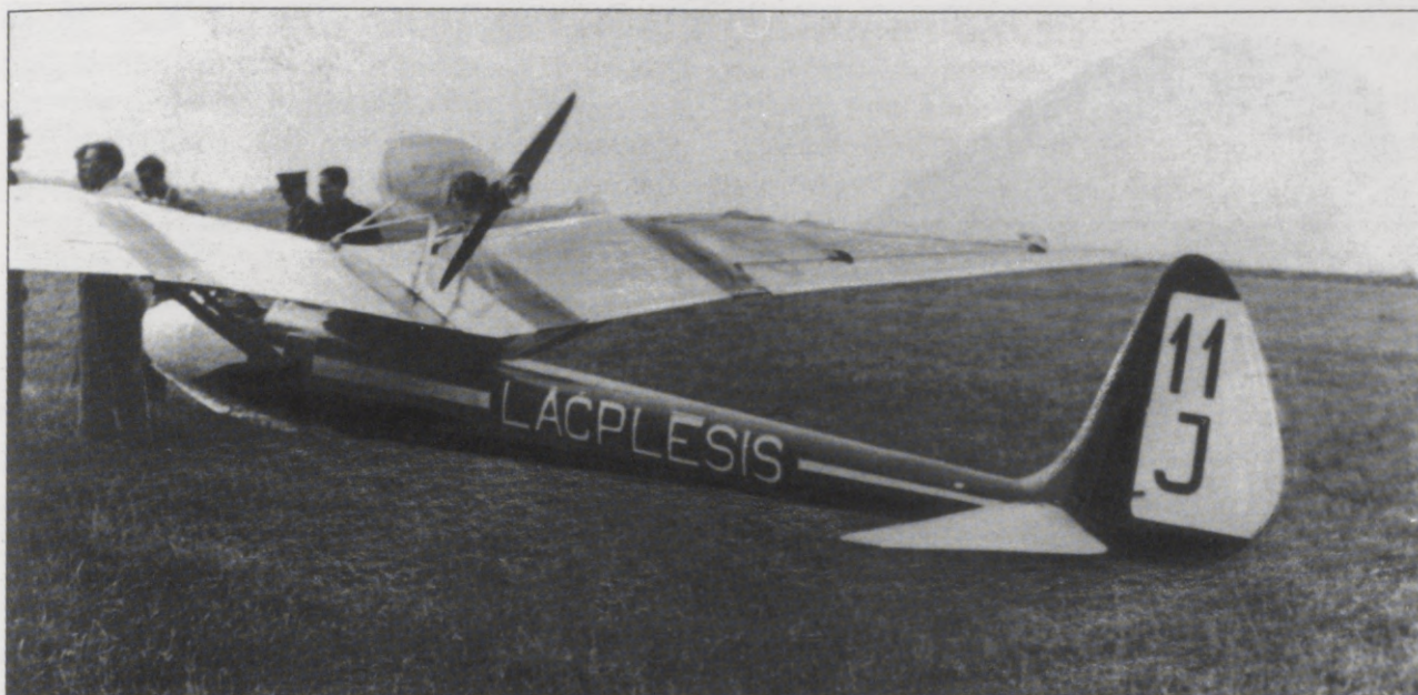
"Lāčplēsis", "Kondor" tipa planieris, kam Latvijas Aerokluba Jelgavas nodaļas planieristi uzstādīja "Kobler" motoru ar gaisa dzesēšanu (foto no A. Panteļejeva personiskā arhīva)
