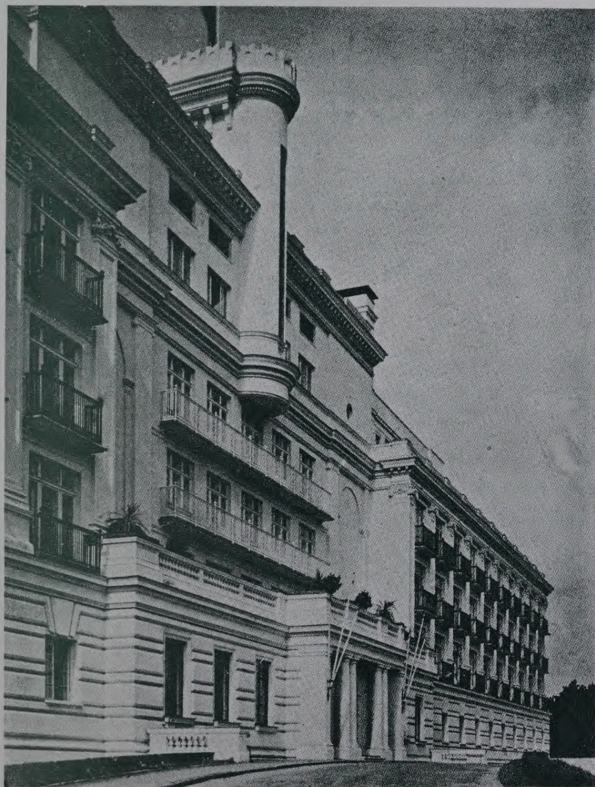
Kemeru viesnīca. Skats no piebrauktuves puses.
