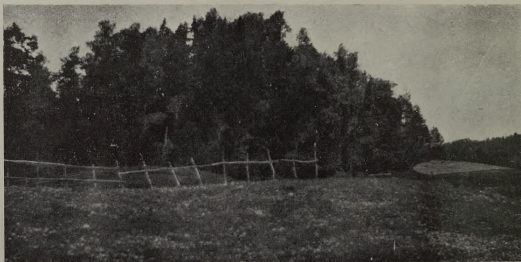
Sērpiņu „Pilskalns“ no austrumiem.
